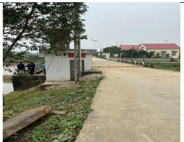
Hình 7. Trạm biến áp
