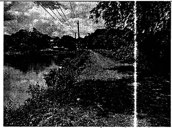
Hình 2. Mặt đập bằng cấp phối
