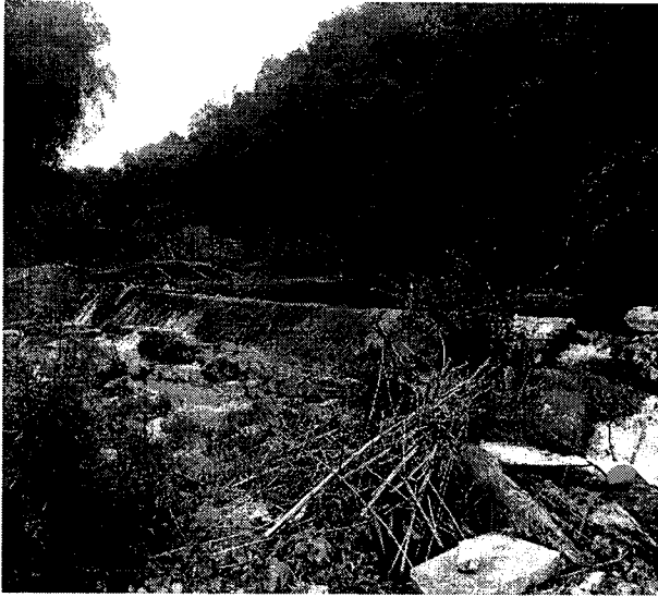
Hình 1. Tuyến đập hiện trạng
